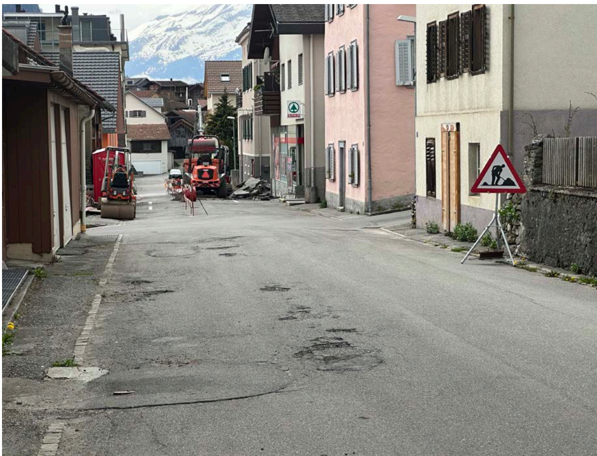
Die Belagssanierung der Von-Salis-Strasse hat bereits begonnen.
