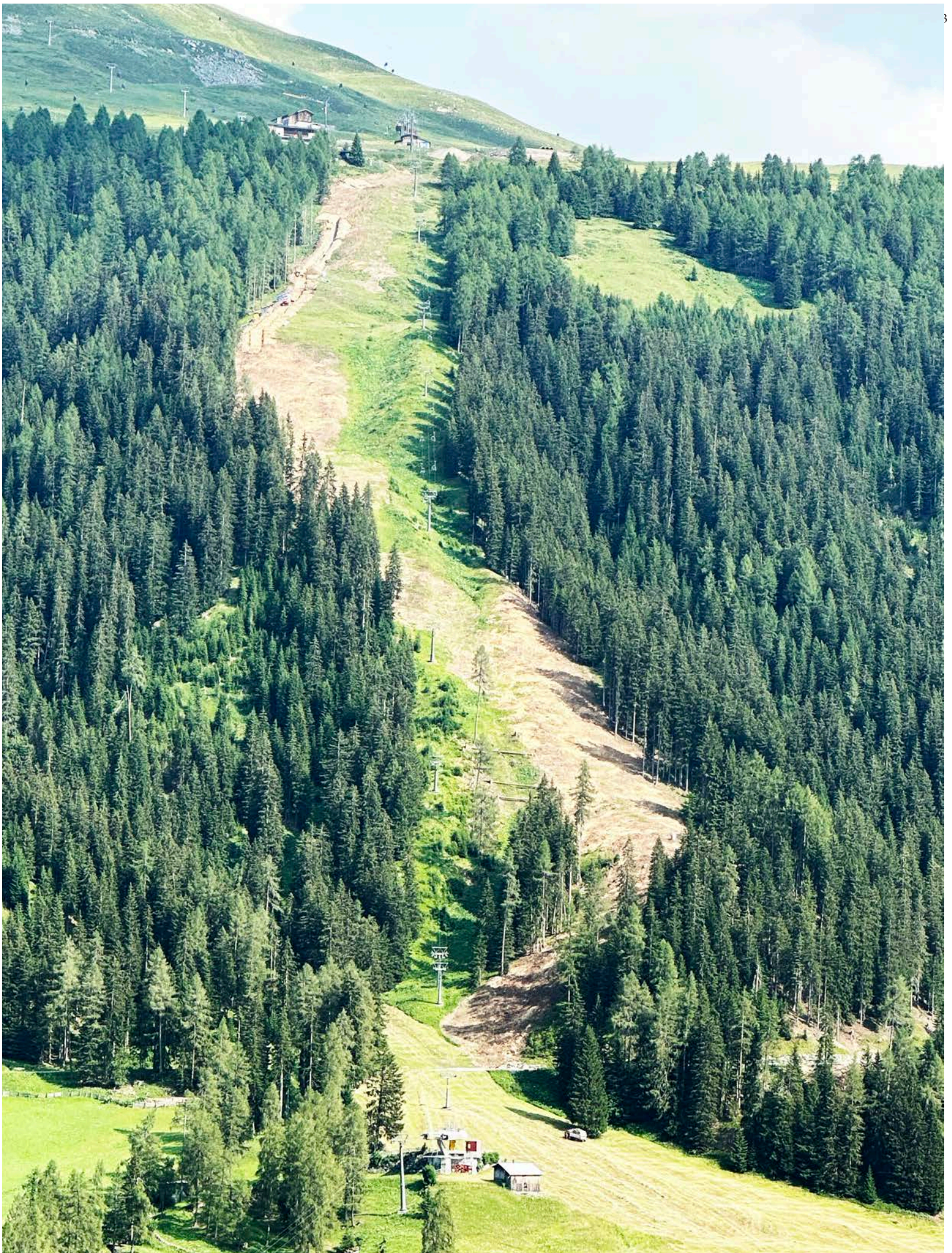
Carjoler – die neue Talabfahrt am Fusse des Jakobshorns, entlang des Sessellifts Carjoler, steht. Gebaut vom einheimischen Weltcupsieger 91/92, Paul Accola auf seinem Menzi-Muck.
