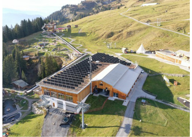
Die Klosters-Madrisa-Bergbahnen AG hat einen namhaften Betrag in die Photovoltaik investiert.
