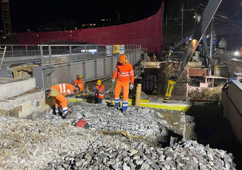
Das neue Trasse wird vorbereitet.
