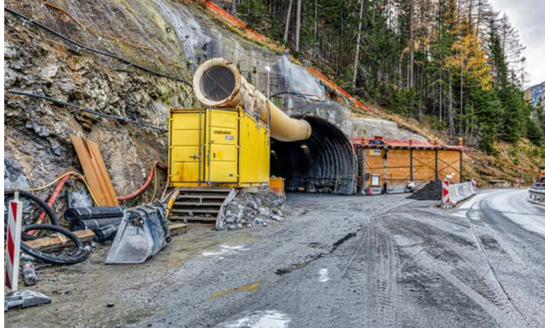
Das Ostportal des Tunnels Val Alpetta. Foto TBA
