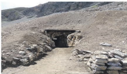
Mundloch des Hauptstollens
