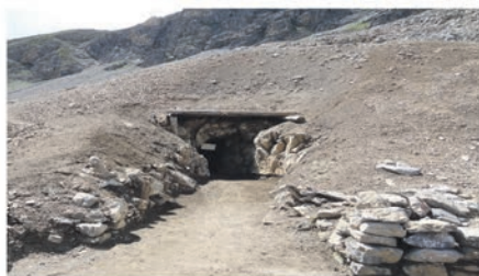
Mundloch des Hauptstollens
