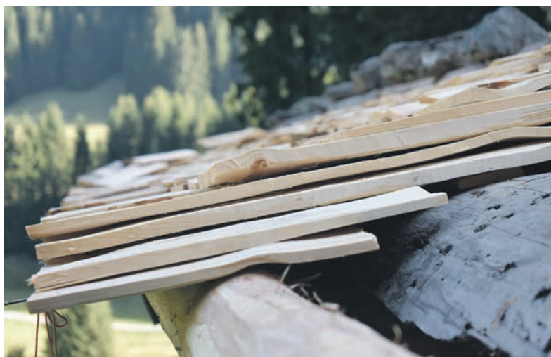
Schindel über Schindel werden gelegt. Insgesamt brauch es für ein solides Dach vier Lagen, damit das Haus geschützt ist.
