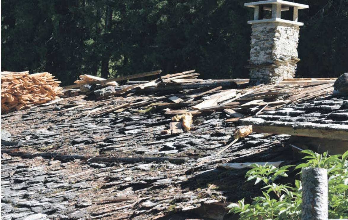
Das Schindeldach auf Masura vorher, in prekärem Zustand...
