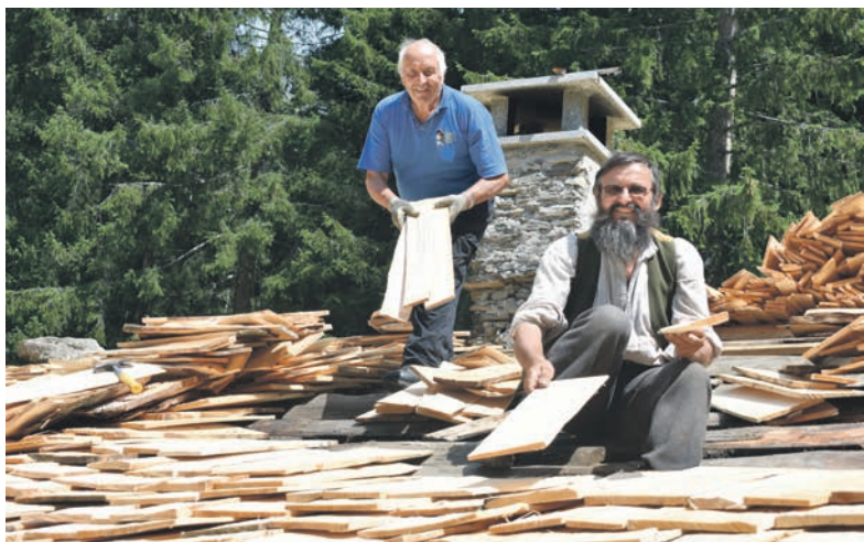
Hans Guler und Hans Flütsch auf dem Dach im Einsatz.
