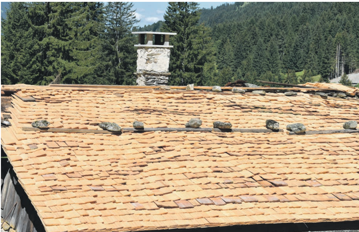
...und nachher glänzt das neue Schindeldach geradezu!
