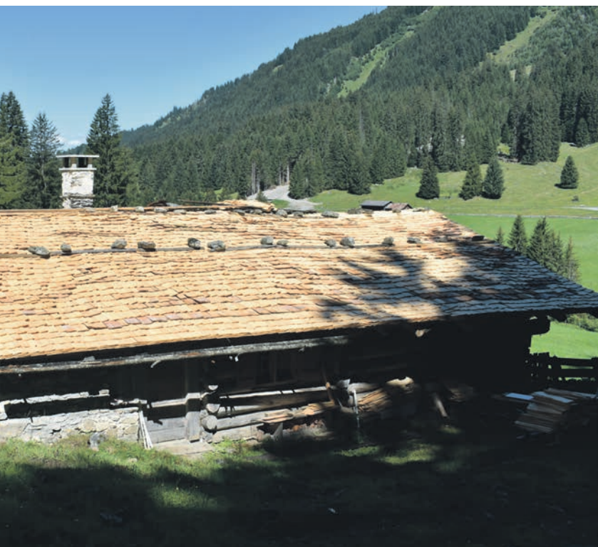
Schindel über Schindel werden gelegt. Insgesamt brauch es für ein solides Dach vier Lagen, damit das Haus geschützt ist.
