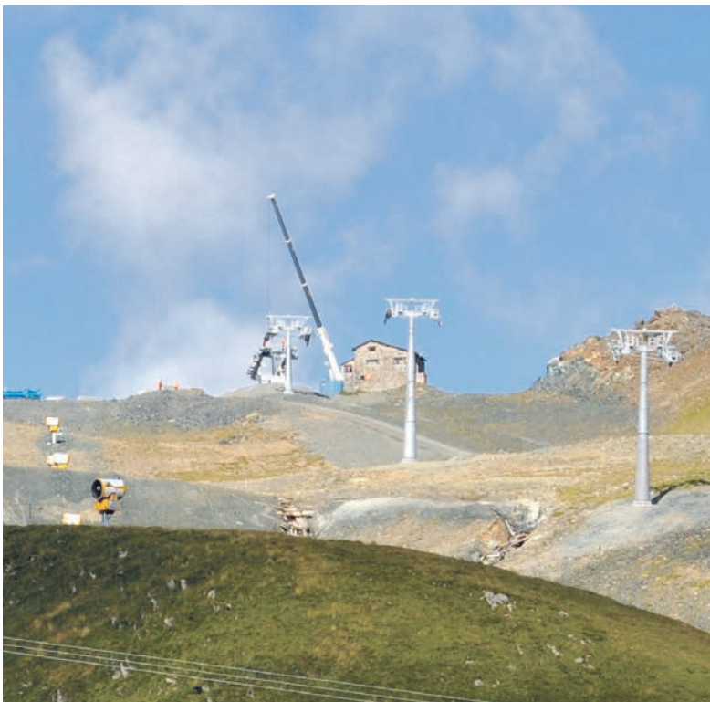
Grosse Kräne unterstützen auf 2000 müM die Montage.
