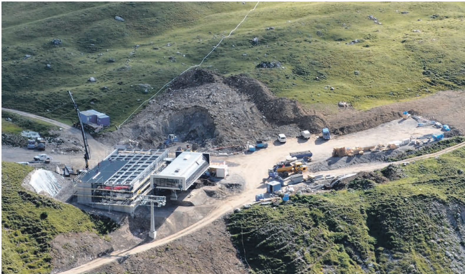
Die neue Bergstation des Furkasesselliftes nimmt Gestalt an.
