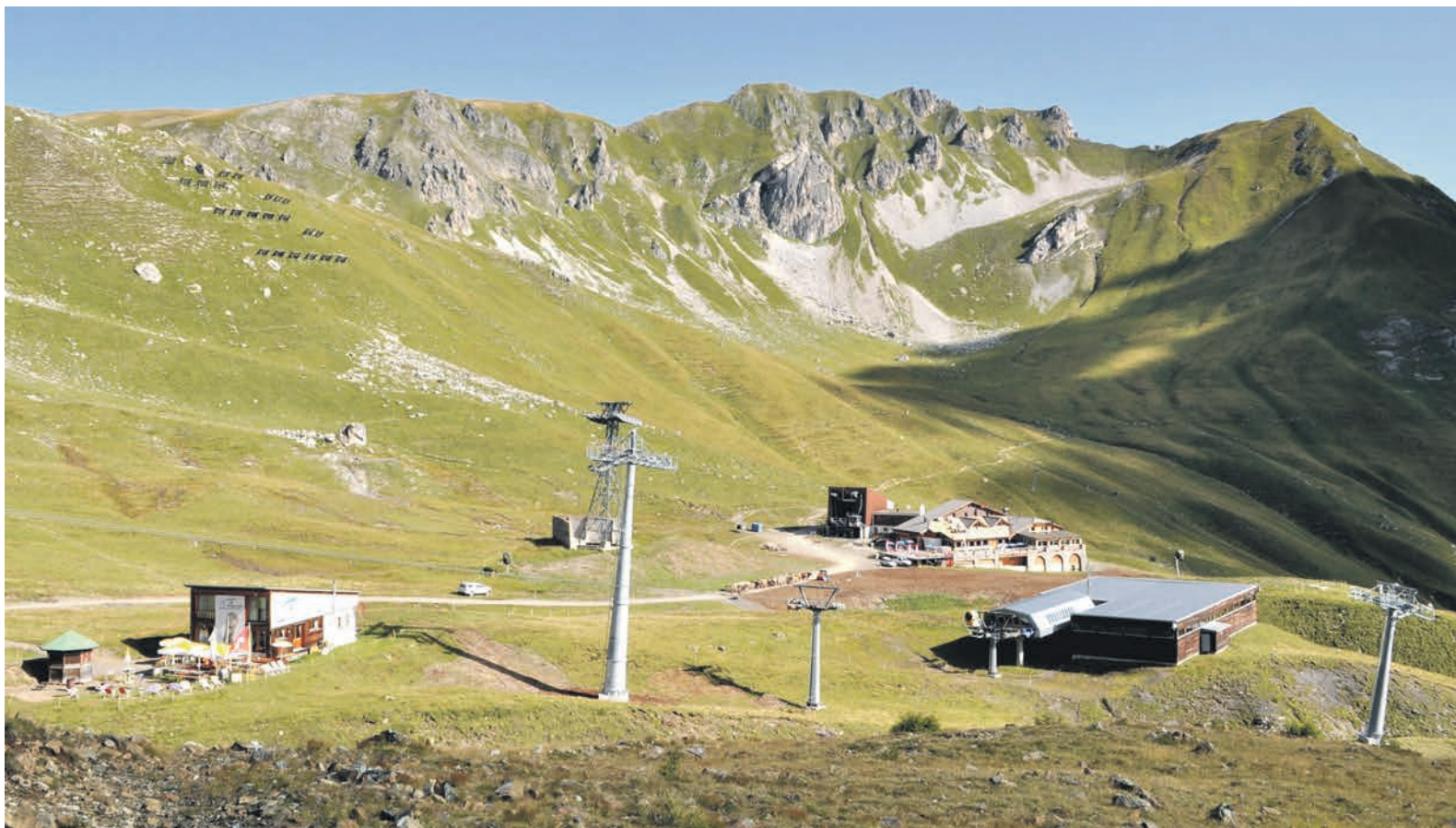
Die Ueberführung Skilift Furkalift wurde entfernt, nun eröffnet sich ein freier Blick auf die Parsennhütte.
