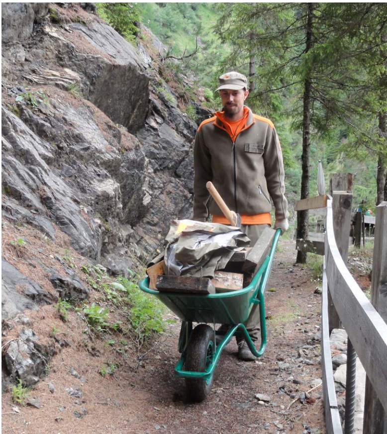
Mit der bewährten, umweltfreundlichen Karette wird das Material transportiert.
