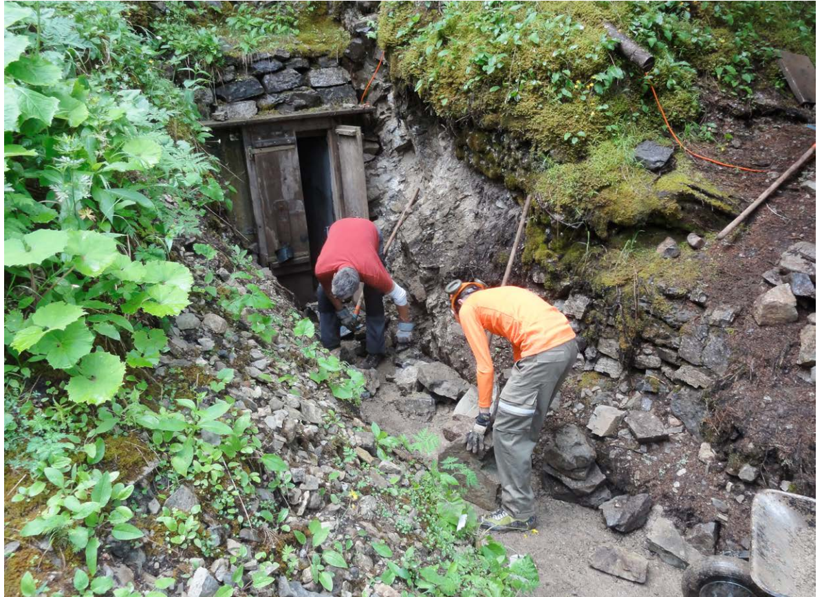
Arbeiten an der Stützmauer beim Neuhoffnungstollen.
