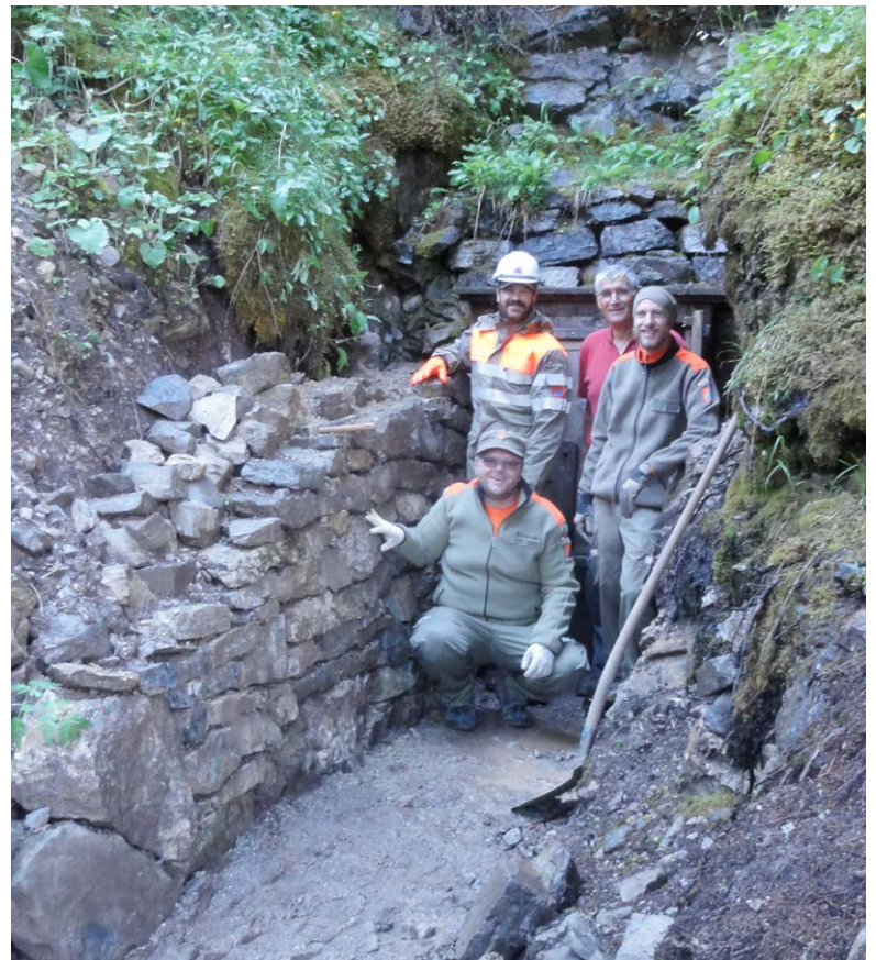
Gruppenbild neben der neu erstellten Stützmauer vor dem Neuhoffnungstollen. Fotos Paul Buol
