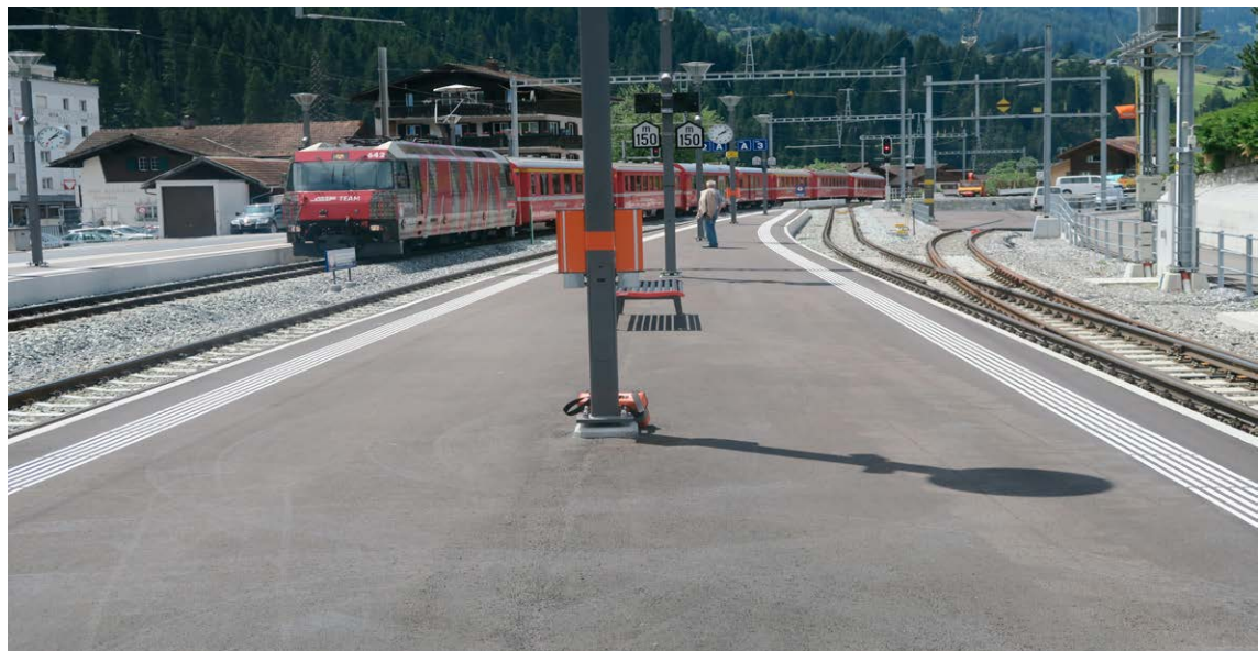
Der neue Kübliser Bahnhof ist dreigleisig. Rechts gibt es sogar noch ein Industriegleis.
