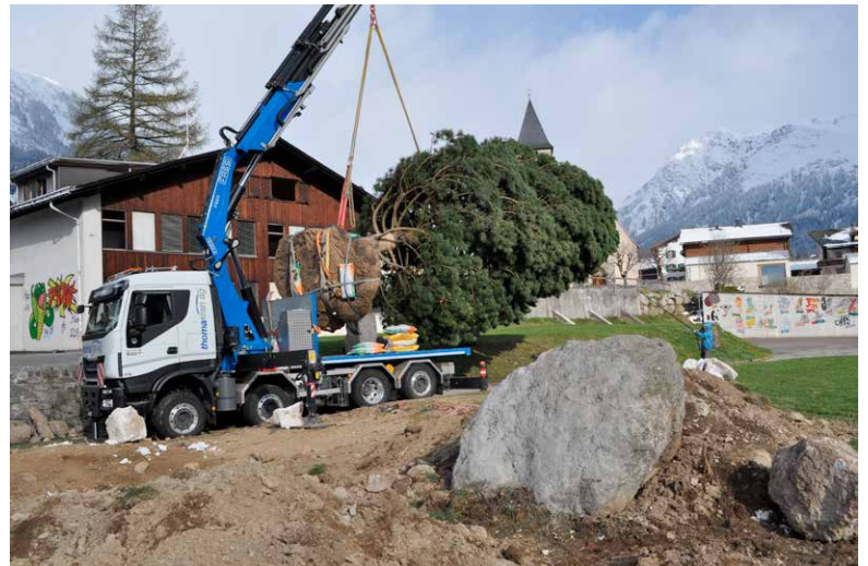
Ein 4 Tonnen schwerer Felsbrocken musste ausgegraben werden, bevor die Spezialisten die Arve freistellen konnten.
